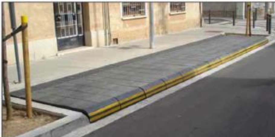
Ilustración 2: Paradas en el borde de la acera sin plataformas externa. Plataforma Bus encajada entre alcorques (Viladecans, Barcelona)
